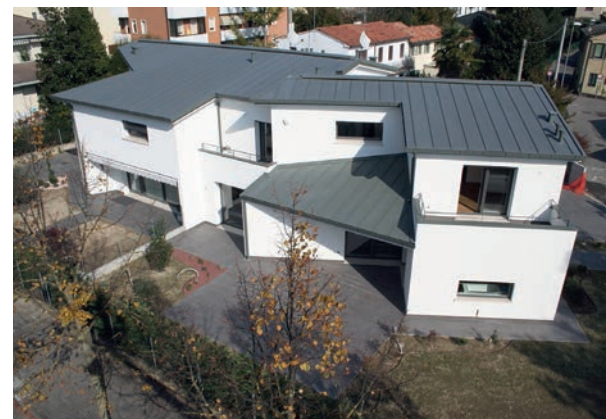
Copertura in doppia aggraffatura d'alluminio preverniciato
